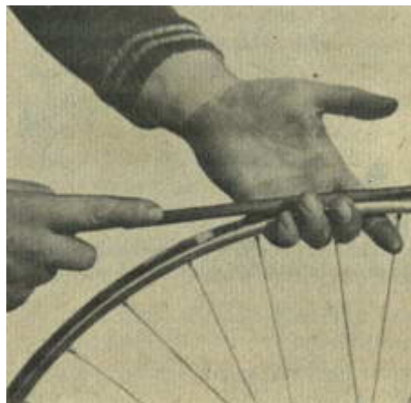
Рис. 7. Спиливание выступающих концов спиц
